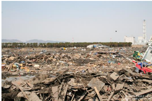
松川浦漁港付近の津波被害 出典：(財)消防科学総合センター 災害写真データベース
