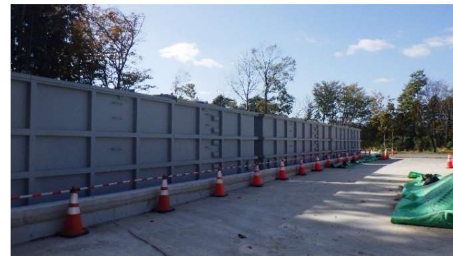
予備水槽の追加設置状況
