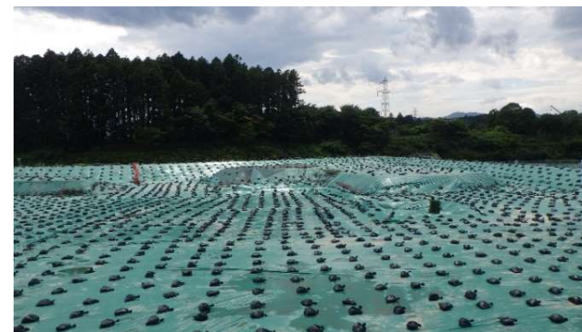
被覆シート未施工箇所への施工状況
