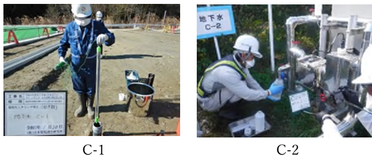
写真 4.4 地下水試料の調査状況
