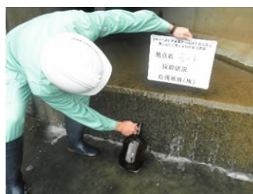
写真 4.6 放出水の調査状況
