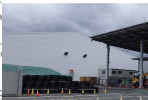
東平封入施設 テント外観
