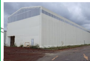
東平灰保管施設
