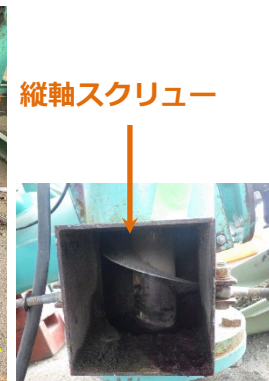
事故発生点検口
