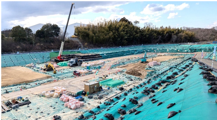
2期埋立地の様子 (令和7年3月埋立地搬入路入口付近から撮影)
