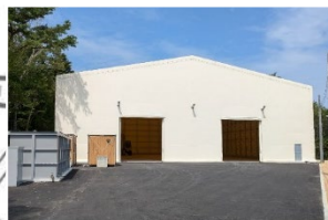
埋立物保管施設
