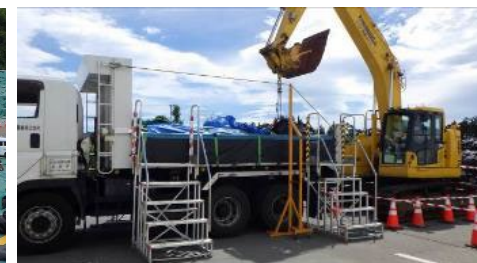
輸送の状況(積込作業)
