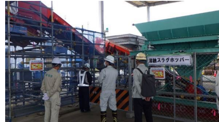
立入禁止柵の設置状況（5月20日）
