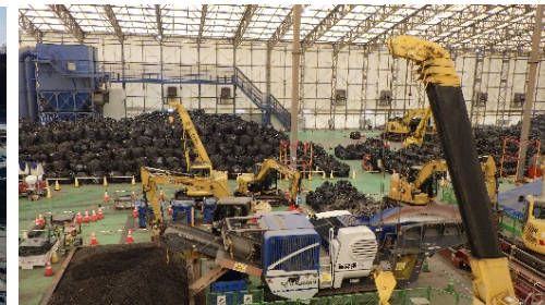
東平封入施設の状況
