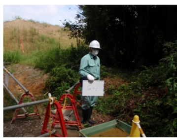
写真4.10 騒音・振動の地点状況
