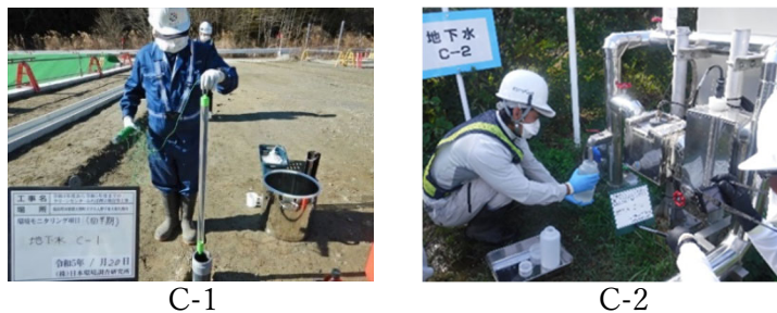
写真4.5 地下水の調査状況
