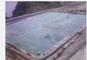
最終処分場 表面キャッピング例
