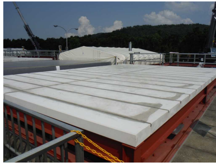
ALC板設置状況
