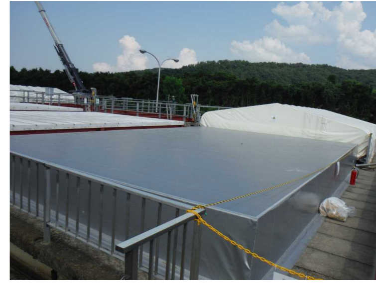
防水シート設置状況
