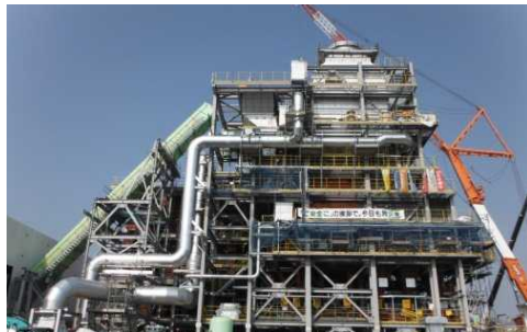
浪江町における仮設焼却施設の建設状況 (平成27年4月)
