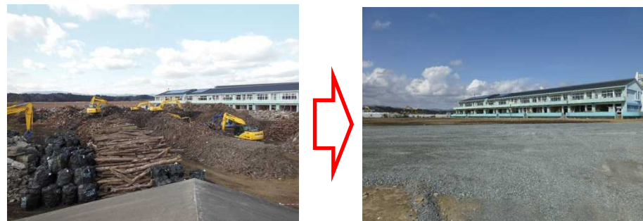
撤去前(平成26年1月)
