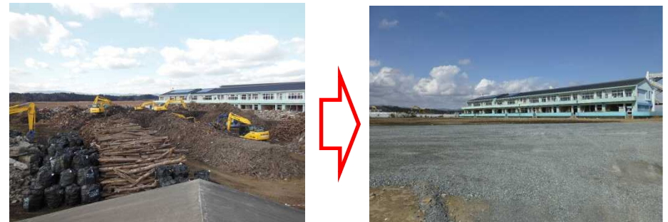
撤去前(平成26年1月)
