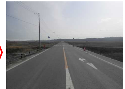
撤去後(平成28年3月)
