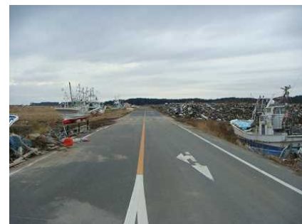
撤去前(平成26年7月)
