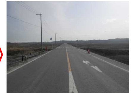
撤去後(平成28年3月)
