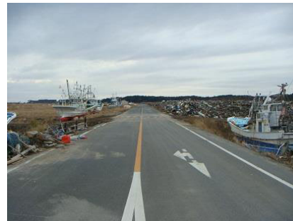
撤去前(平成26年7月)
