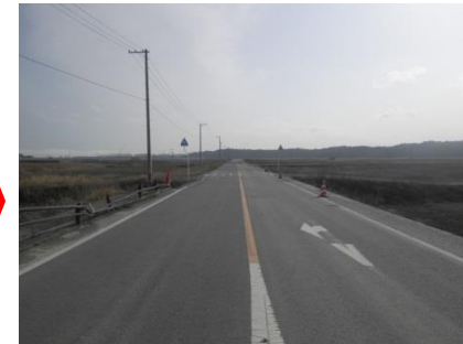
撤去後(平成28年3月)
