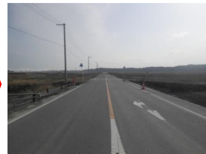
撤去後(平成28年3月)
