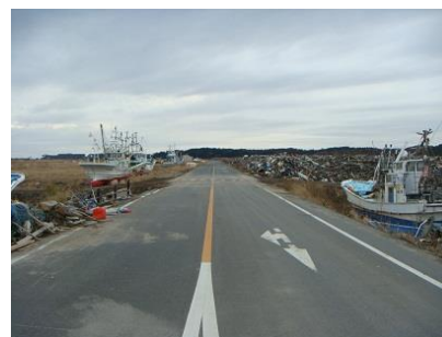
撤去前(平成26年7月)
