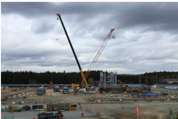
大熊町の仮設焼却施設(工事中)(平成29年4月)
