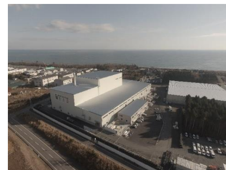
大熊町の仮設焼却施設
