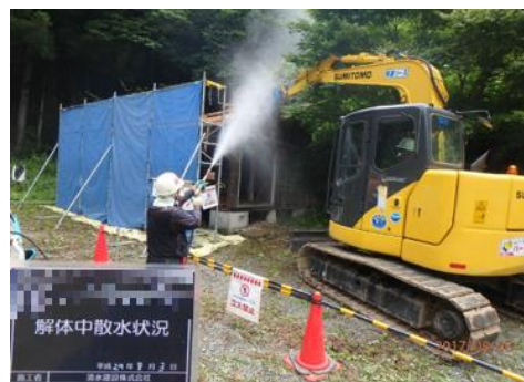
被災家屋等の解体の様子
