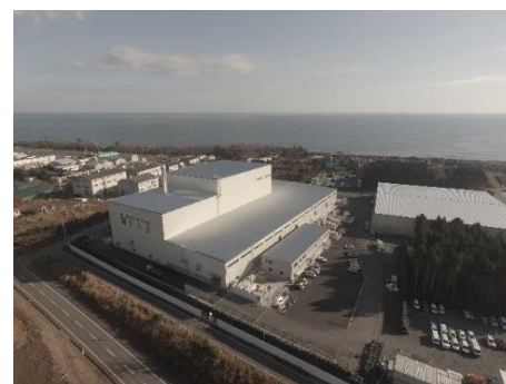
大熊町の仮設焼却施設
