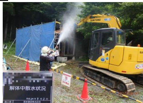
被災家屋等の解体の様子
