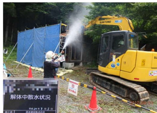
被災家屋等の解体の様子
