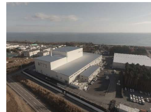
大熊町の仮設焼却施設
