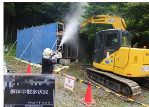
被災家屋等の解体の様子
