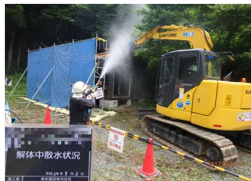
被災家屋等の解体の様子
