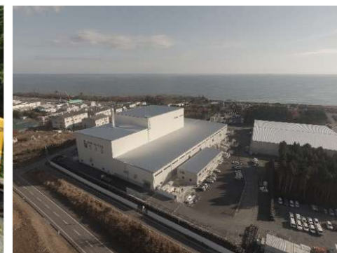
大熊町の仮設焼却施設
