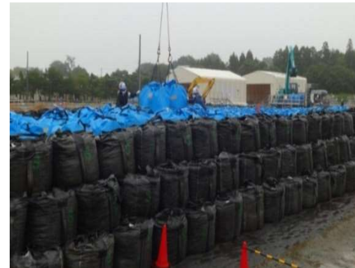
保管場への定置作業
