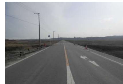
撤去後(平成28年3月)
