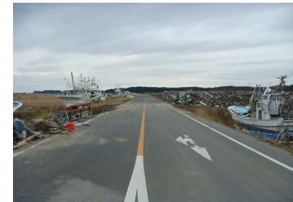
撤去前(平成26年7月)
