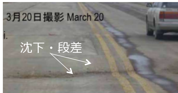
未施工部分 平行誘導路
