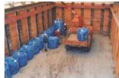
廃棄物定置作業
