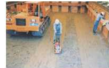
覆土施工状況
