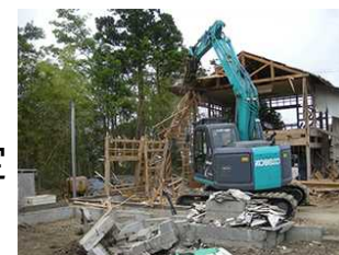
被災家屋等の解体
