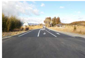
舗装厚改良工事後の 道路の様子(県道251号線)
