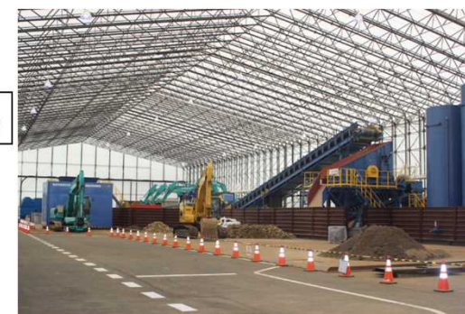
受入・分別施設(大熊1期②工区)
