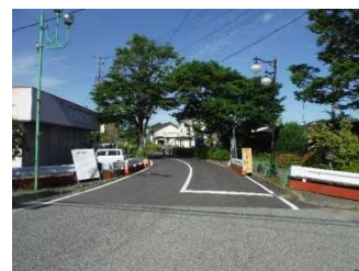
舗装厚改良工事後の 道路の様子(町道下条・細谷線)
