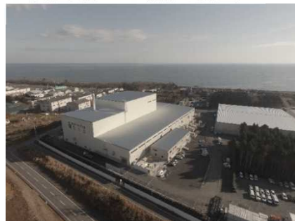
大熊町の仮設焼却施設
