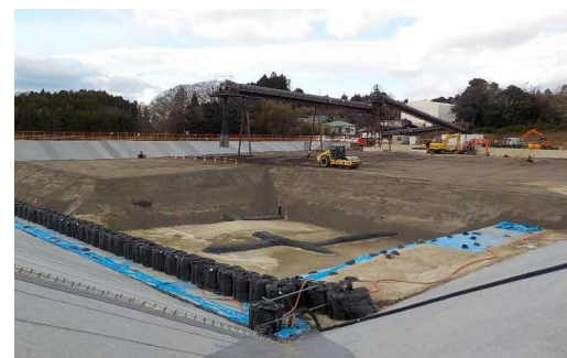
土壌貯蔵施設(双葉1期①工区)
