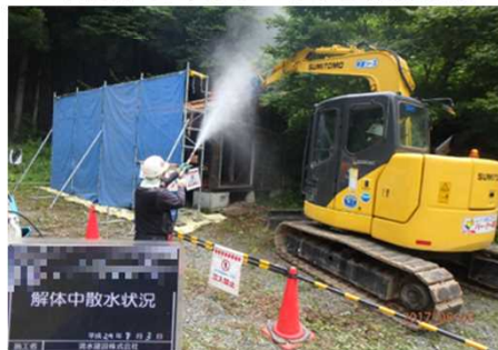
被災家屋等の解体の様子
