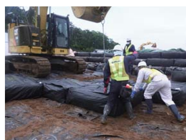
下流側区画:地盤改良用収納容器の埋立て
