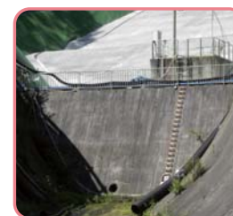
コンクリート堰堤
