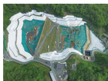
埋立処分施設全体
