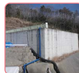
浸出水調整槽
