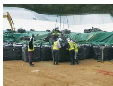
上流側区画:角型収納容器の埋立て
