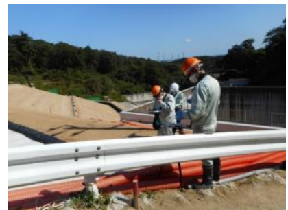
地点 D : 下流側区画の南側(変更後)
