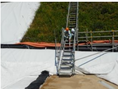
地点 C : 下流側区画の北側(変更後)
