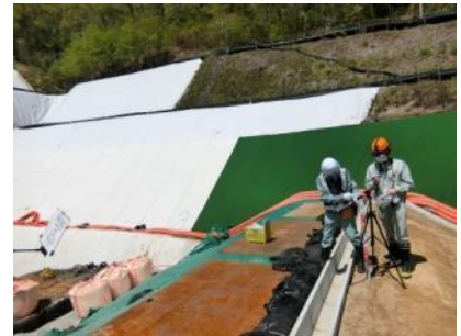
地点 C : 下流側区画の北側(変更前)
