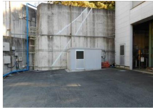
ユニットハウスの状況
