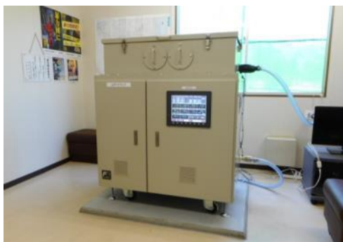
業務棟の測定装置
