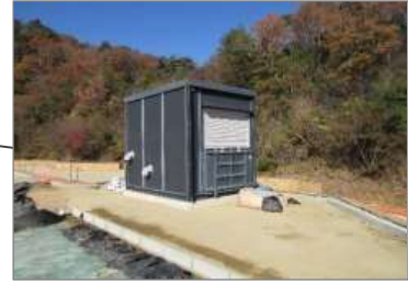
埋立地北側 (ユニットハウス外観)
