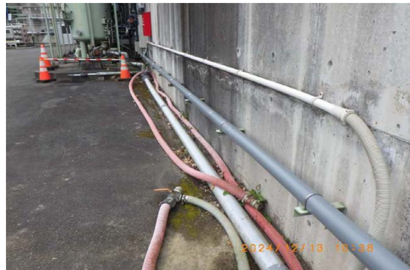
補修後（令和6年12月13日時点）
