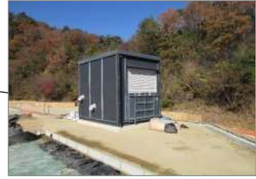
埋立地北側 (ユニットハウス外観)
