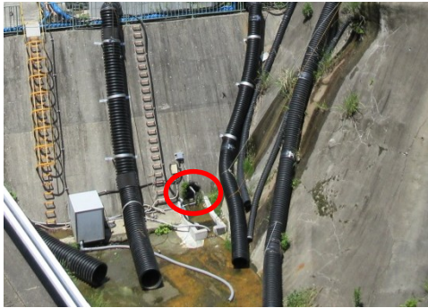
地下水採取地点(○印地点)
