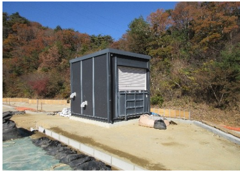
埋立地北側(ユニットハウス外観)
