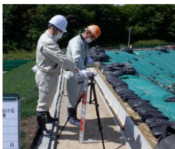
地点 D : 下流側区画の南側
