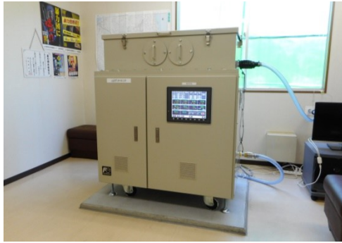
業務棟の測定装置
