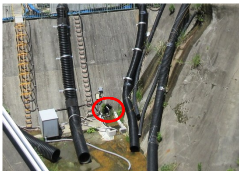
地下水採取地点(○印地点)
