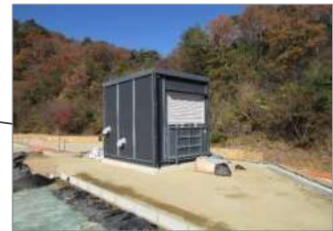
埋立地北側 (ユニットハウス外観)
