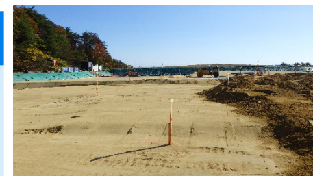
埋立地上流北側
