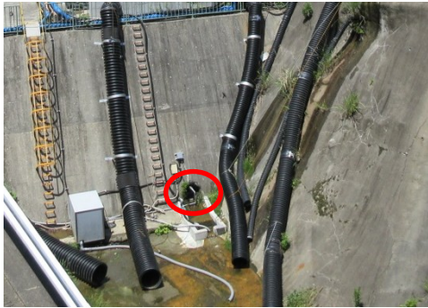
地下水採取地点(○印地点)
