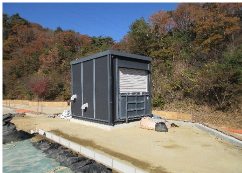
埋立地北側(ユニットハウス外観)
