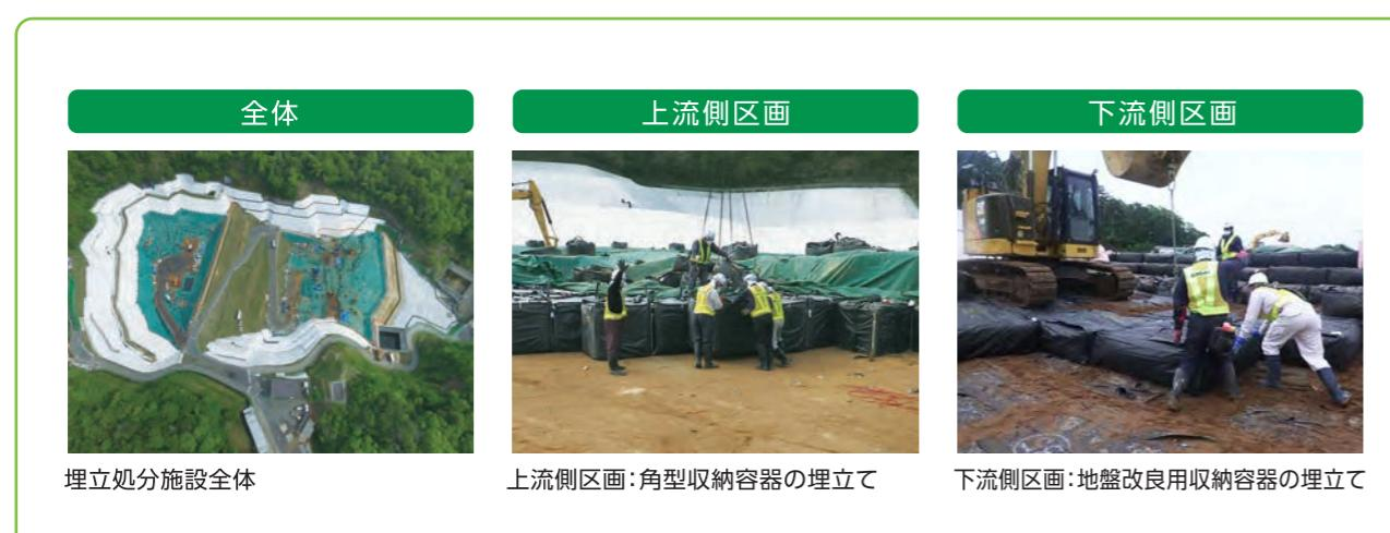
放射性セシウムが埋立地外へ漏出しないよう多重の安全対策を実施します。
