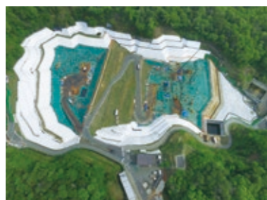
埋立処分施設全体
