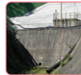
コンクリート堰堤
