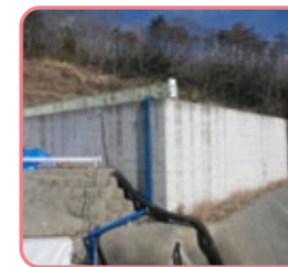
浸出水調整槽
