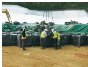
上流側区画：「セメント固型化した廃棄物」と「セメント固型化しない廃棄物」の埋立場所
