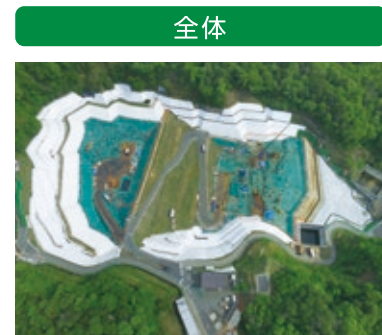
埋立処分施設全体
