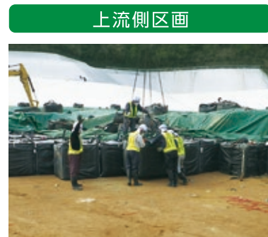
上流側区画: 「セメント固型化した廃棄物」と 「セメント固型化しない廃棄物」の埋立場所
