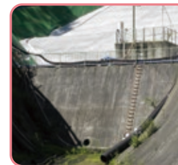
コンクリート堰堤
