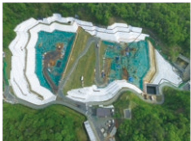
Specified Waste Landfill Site
