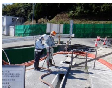
地点 D：下流側区画の南側
