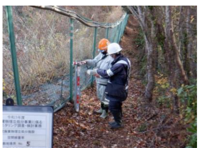
No. 5 下流側区画の南側
