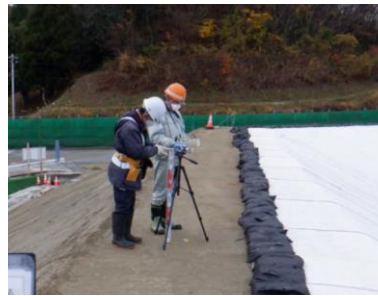
地点 D：下流側区画の南側
