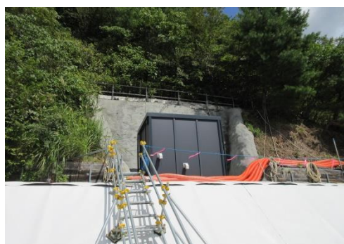
埋立地北側(ユニットハウス外観)
