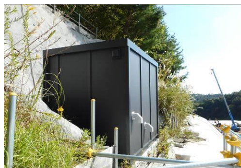
埋立地北側(ユニットハウス近景)
