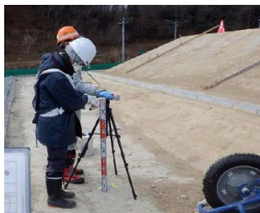
地点 D：下流側区画の南側
