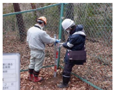
No. 4 下流側区画の北側
