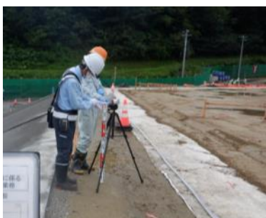
地点 D：下流側区画の南側
