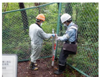
No. 4 下流側区画の北側
