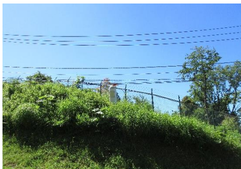
正門付近の測定装置
