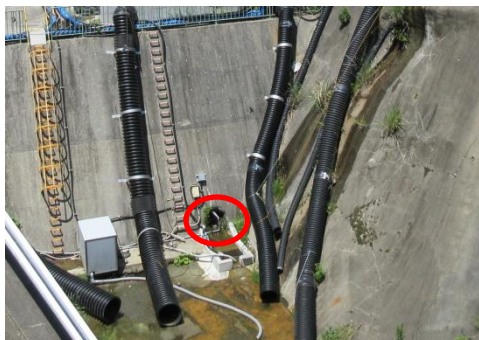
地下水採取地点(○印地点)
