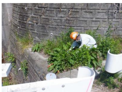
調査地点④ (撮影日:令和5年5月17日)
