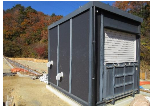
埋立地北側(ユニットハウス近景)
