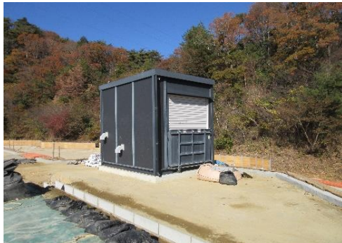
埋立地北側(ユニットハウス外観)
