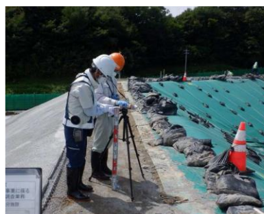
地点 D：下流側区画の南側
