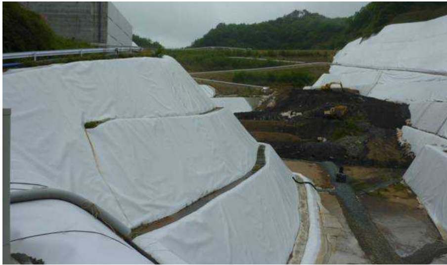
図2 2012年5月23日の現場状況（右岸側より埋立地を撮影）
