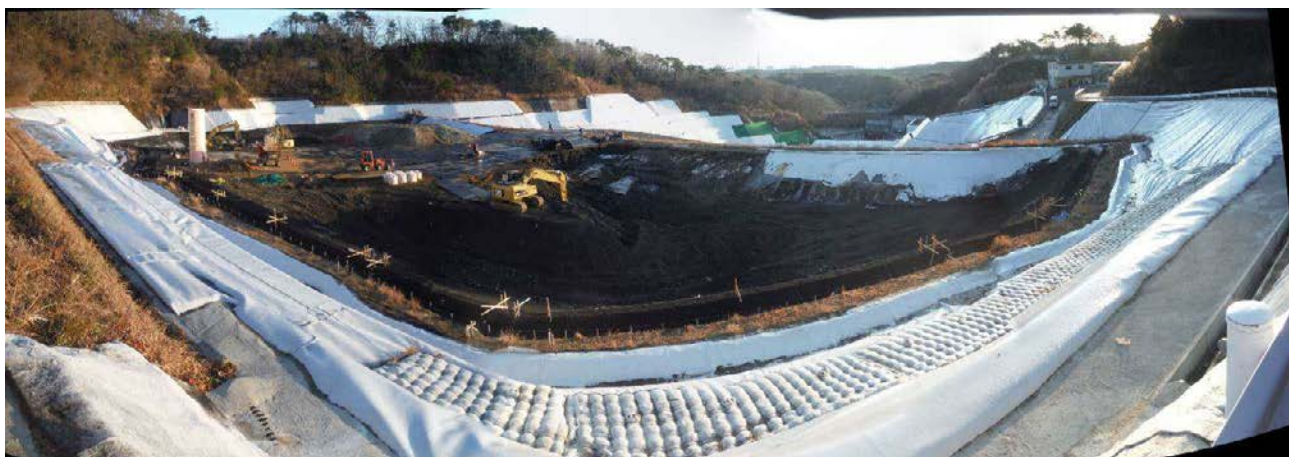
図-1.2(1) 西門付近より上流側埋立地
