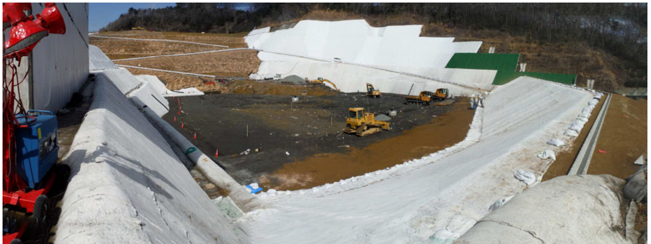
図-1.2(2) 新設調整槽より下流側埋立地
