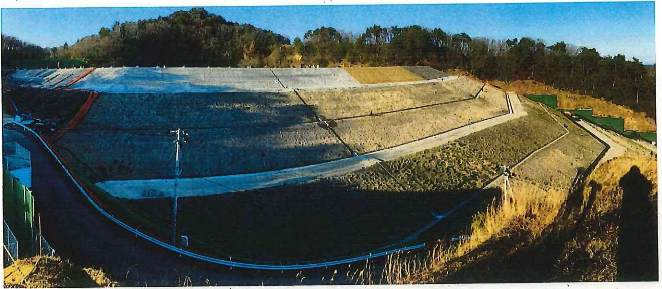
図-1.2 南側から上流側埋立地を撮影
