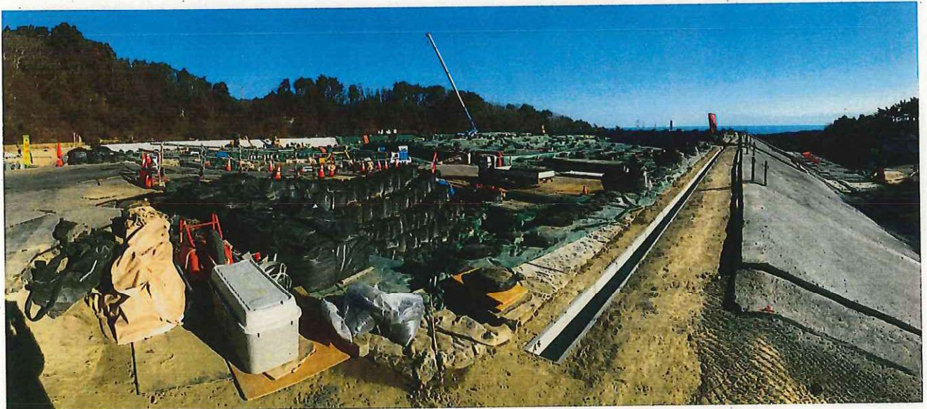
図-1.3 上流側埋立地を撮影
