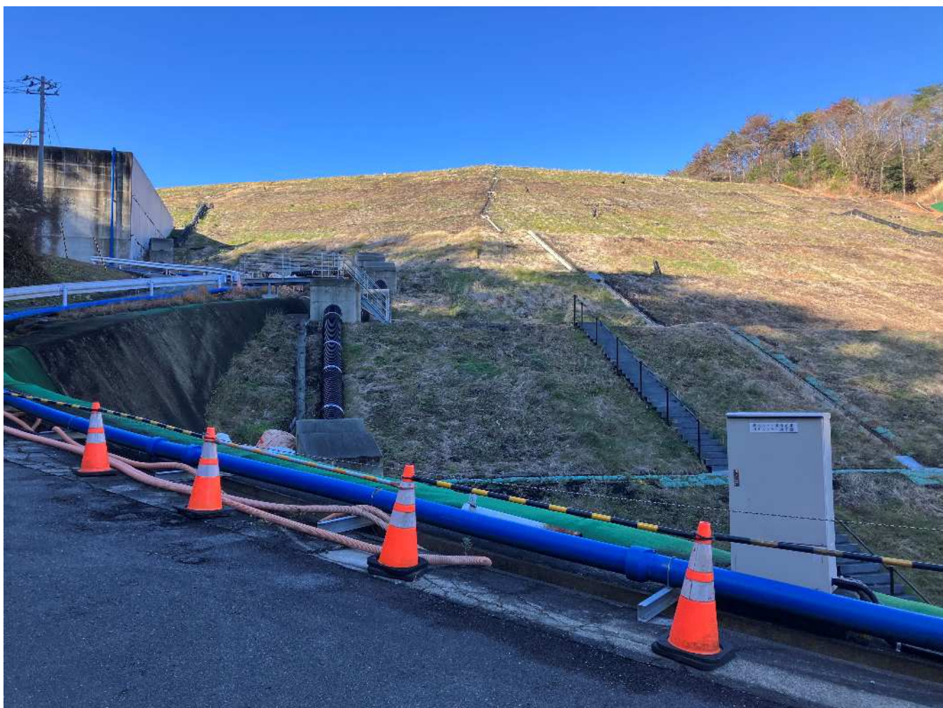
図-1.2 下流中継端子盤付近より埋立地(土堰堤)側
